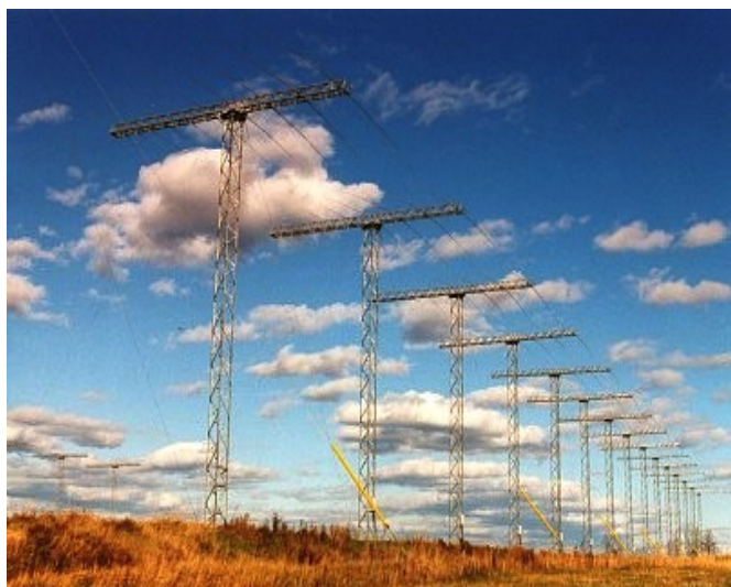
Die 15 Beam-Antennen eines Kurzwellen-Überhorizontradars. Sie nutzen die Ionosphäre als Reflektor. Doch was haben ihre Impulse in exklusiven Amateur-Kurzwellenbändern zu suchen?
