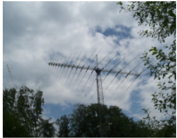
Abb. 6 + 7: Die Funkkontroll-Messstelle der BNetzA in Konstanz mit 18-El.-Logperiodic dort im Freigelände Bilder: DJ9KR
