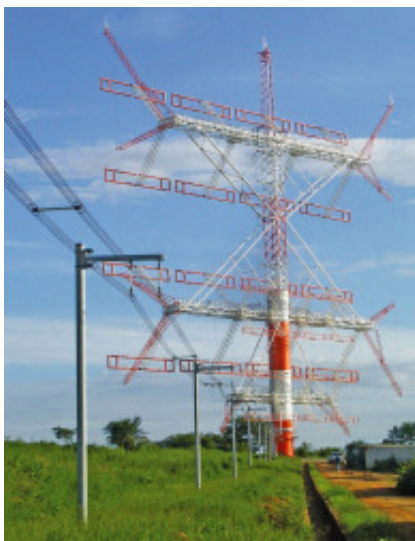
Abb. 4 : Die drehbare Antenne bei Radio Bangladesh, Hersteller: Thomson Broadcast, Typ HP-RCA-2/2/0.5 Quelle: www.thomson-broadcast.com
